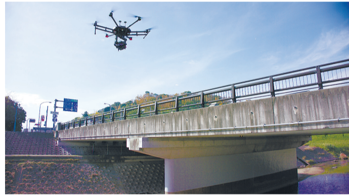
奈良県王寺町の橋梁をドローンで点検し、8K映像の有効性を確認した
